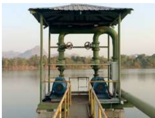
เครื่องสูบน้ำจากบ่อพักน้ำดิบของโครงการ
