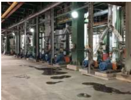
รูปที่ 23 เครื่องจักรที่มีการปิดครอบและแท่นวางเพื่อลดระดับเสียงและการสั่นสะเทือน
