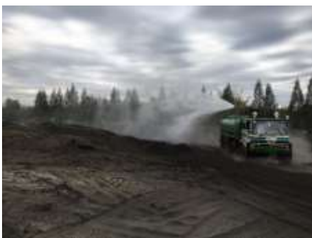
รูปที่ 12 ฉีดพรมน้ำฝูหน้ากองเถ้า
